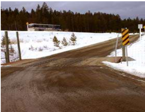
通行遮断材（テキサスゲート）外観
