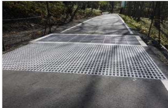
日光国立公園に設置された通行遮断材（グレーチング）
