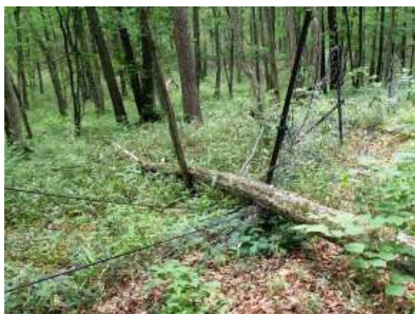
台風等による強風等で柵は簡単に崩壊
