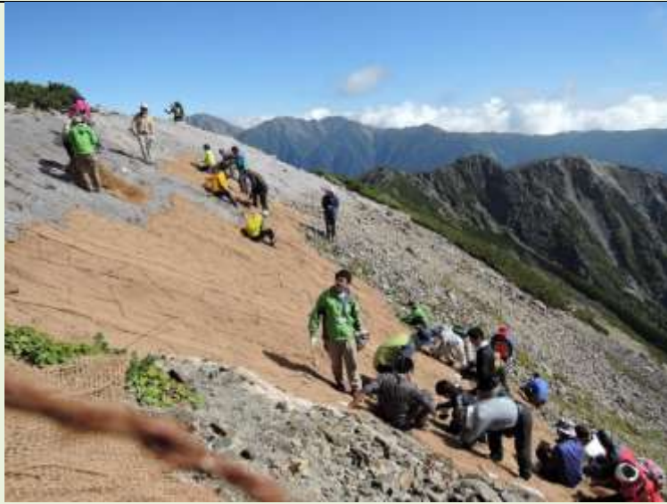
植生マットの設置状況
