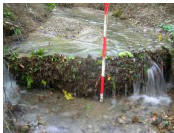
落ち葉や落ち枝が堆積→砂や石が堆積 →水流の堰き止め→柵の崩壊
