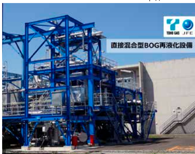
消費電力の大幅削減と建設コスト抑制を両立
