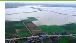
集中豪雨による農地の湛水被害
