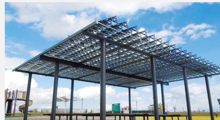
木かげの涼しさを人工的に再現したフラクタル日よけ「エアリーシェード」 出所)積水化学工業株式会社
