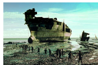
労働安全・環境対策がされていない途上国の解体施設
