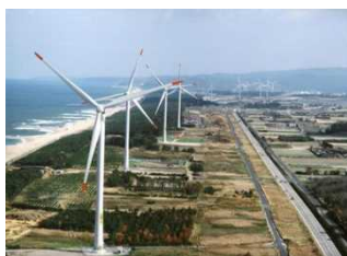
写真 北条砂丘風力発電所
