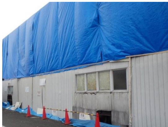
図3.6 応急飛散防止措置の例
