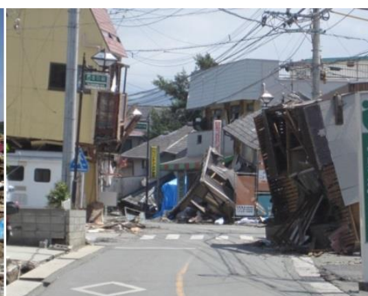
損壊建物（地震）
