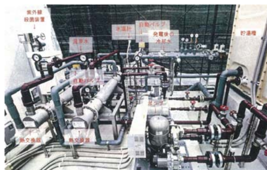
養殖のための熱交換システム全景
