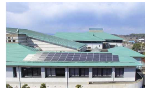
太陽光発電設備 (熊本県御船町)
