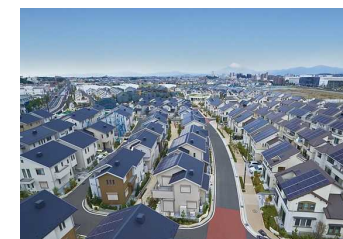
スマートタウンの戸建住宅
