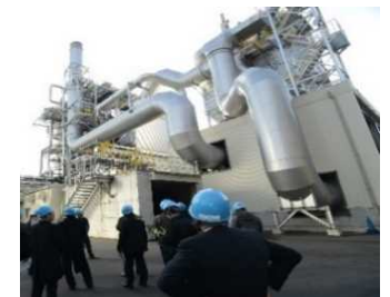
木質バイオマス発電所
