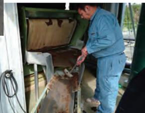
中水処理施設の汚泥物を除去して客室の便所洗浄水や社用車の洗車に再利用
