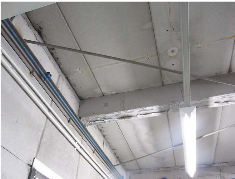
③石綿含有耐火被覆塗り材
