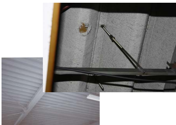
レベル 2: 屋根用折板石綿断熱材
