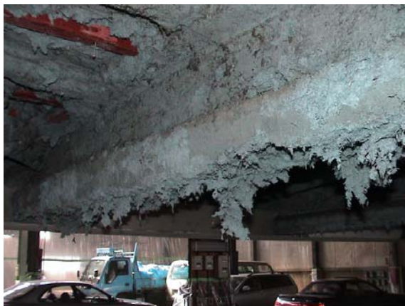
レベル1: 吹付け石綿（クロシドライト）
