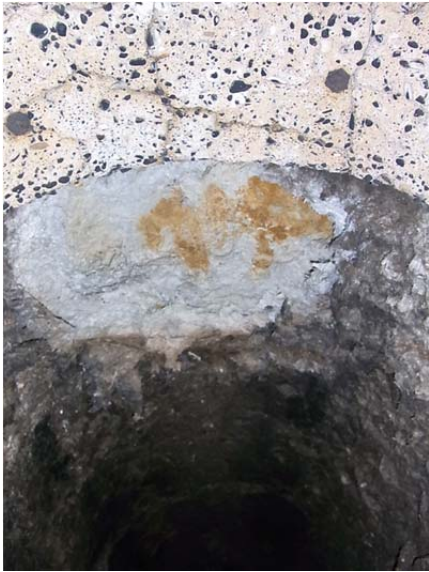
①煙突用石綿断熱材
