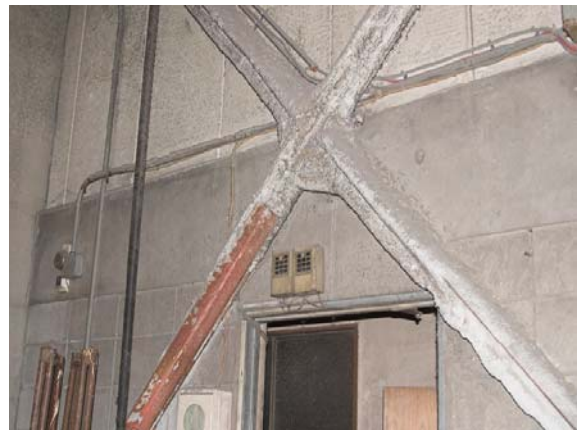
レベル 1: 吹付け石綿（クリソタイル）
