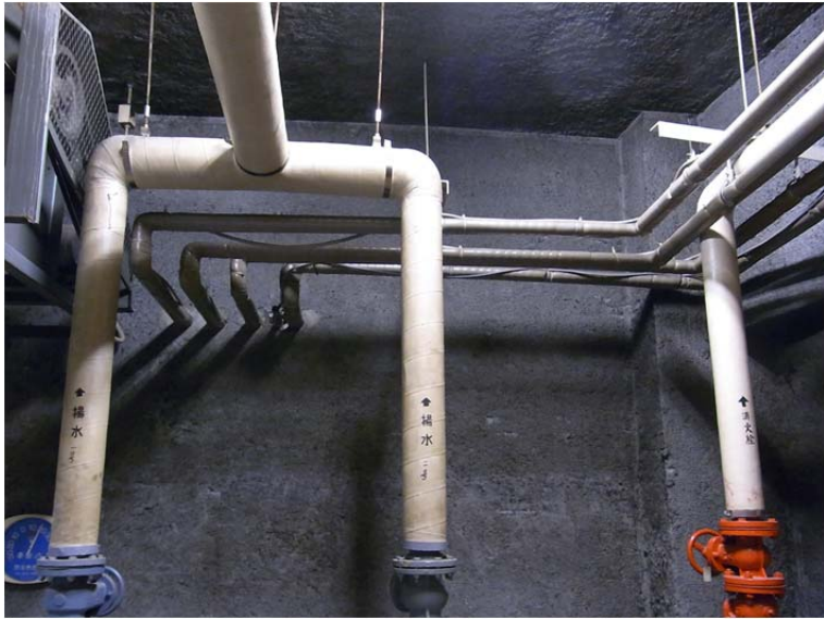
①吹付け石綿(クロシドライト)
