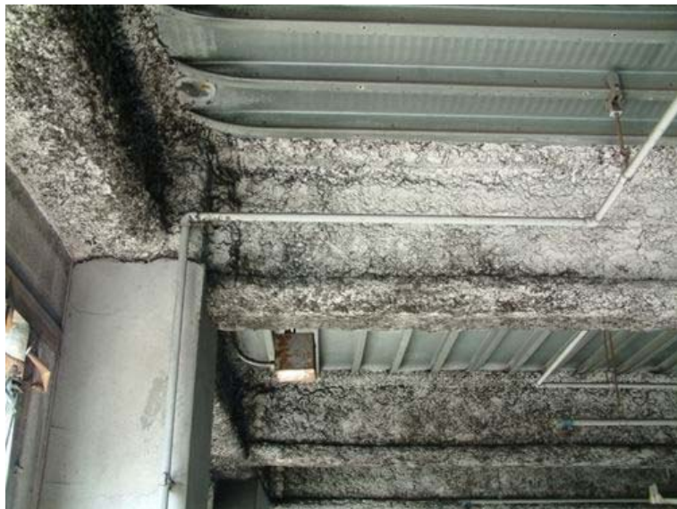
②石綿含有吹付けロックウール
