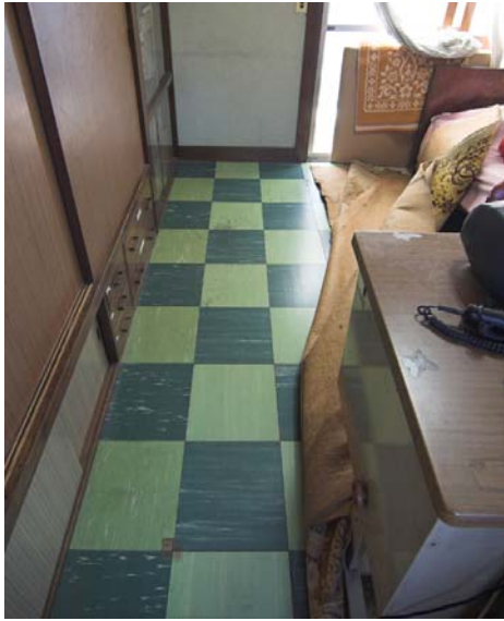
①石綿含有ビニル床タイル
