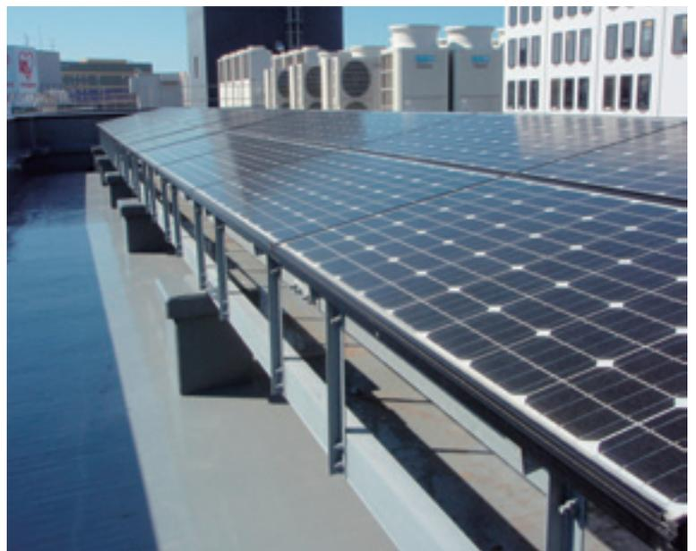
FKビル再生エネルギー太陽光発電設備5.02kw
