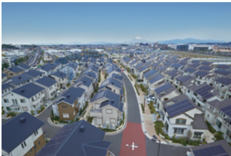
太陽光パネル、蓄電池、スマートHEMSシステムを全戸に導入
