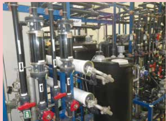
写真1 糸満市浄化センターに導入されたパイロットプラント (中野 義勝氏提供)
