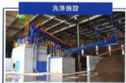
洗淨施設 洗淨処理施設 重金属汚染土を水洗浄することで汚染物質を分離・除去し、無害化処理を行います。 処理能力 30t/日×24h=720t/日
