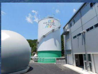
乾式メタン発酵施設
