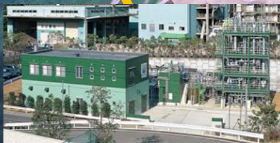
浸出水処理施設
