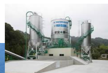
造粒固化施設
