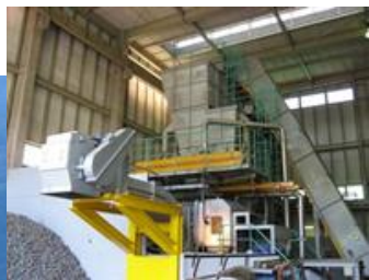
固形燃料化施設
