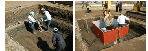
試験施工の様子
