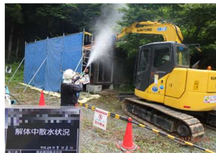
被災家屋等の解体の様子
