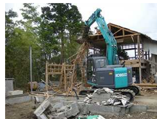
被災家屋等の解体
