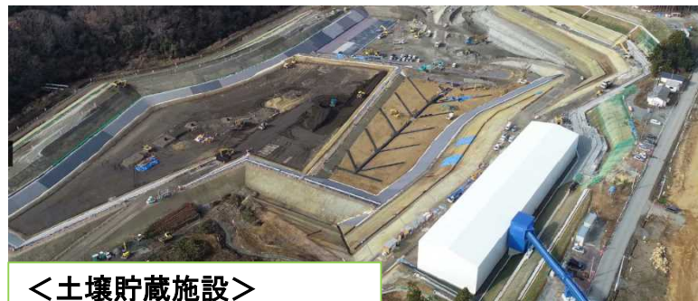
<中間貯蔵施設> (大熊②工区 土壌貯蔵施設(右手前が1期、他は2期) 清水JV)
