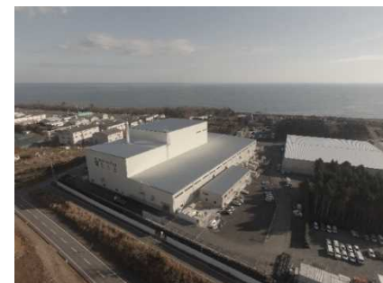
大熊町の仮設焼却施設
