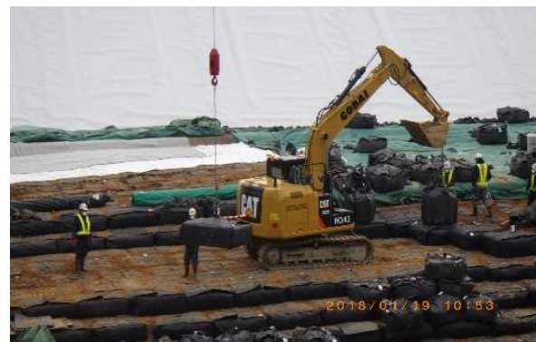
地盤改良用収納容器を埋め立てる様子
