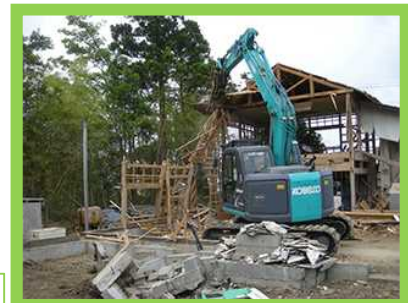
被災家屋等の解体
