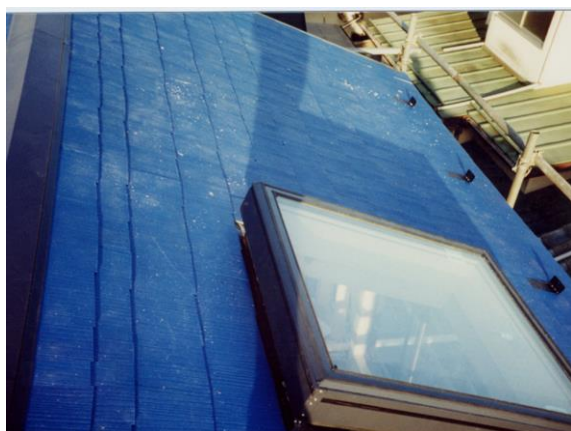
③石綿含有成形板等:住宅屋根用化粧用スレート
