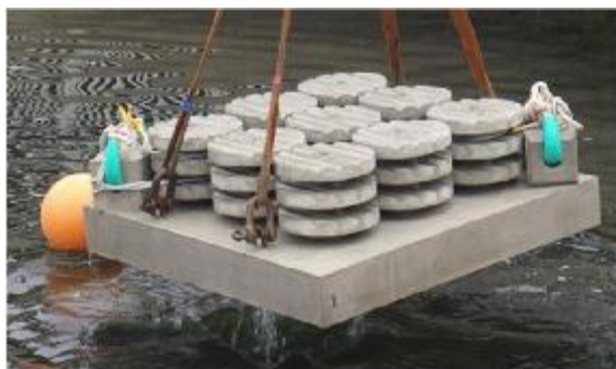
事業①：コンクリートブロックを用いた水質の改善・生物生息の場の創出
