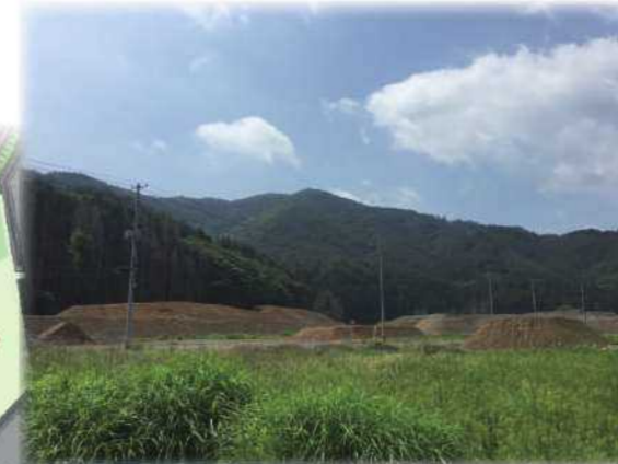
ガーデン側から見た県道 192 号周辺
