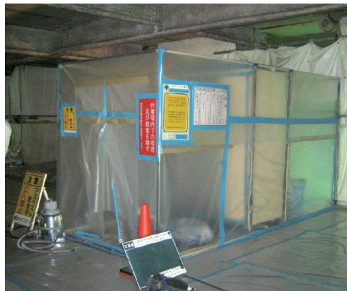
図 3.40 セキュリティゾーン外観
