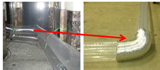
図3.53.1 排気ダクトの例
