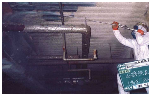
図 3.56 ウォータジェット工法の例
