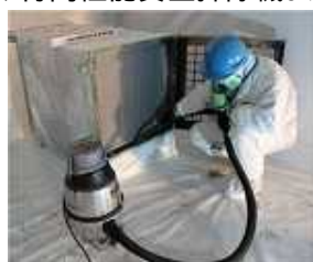
図 3.38 HEPA フィルタ等の清掃
