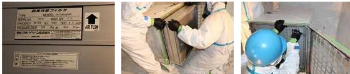
図 3.41 フィルタの取り付け
