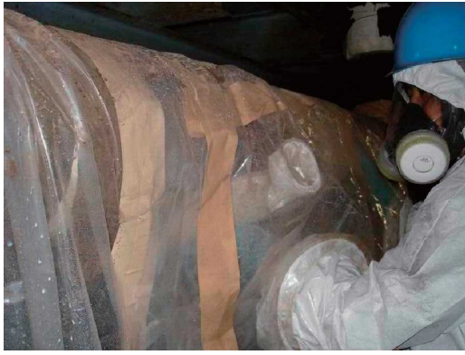
图 3.98 石棉除去作業中 2
