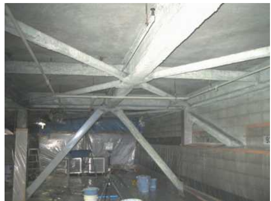
図 3. 15 同上施工区画の内部側
