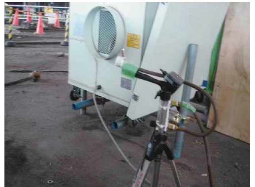
図 3.93 環境測定（作業中）
