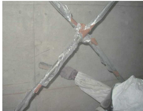
図 3.65 ワイヤブラシを用いた擦り落とし作業（ブラッシング）
