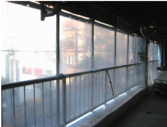
図 3.36 外壁の飛散防止措置例（外部側にメッシュシート張り，内部側に隔離用プラスチックシート張り）
