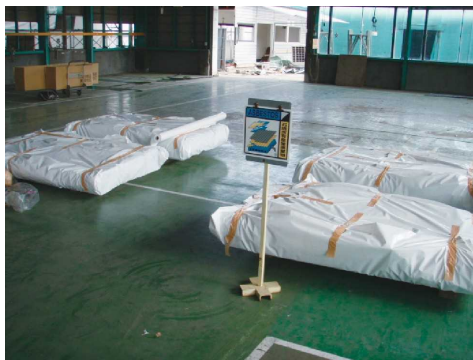
図 3. 116 石綿含有成形板廃棄物の保管例
