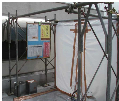
図 3. 44 セキュリティーゾーン前に設置した石綿障害予防規則に基づく表示及び掲示
