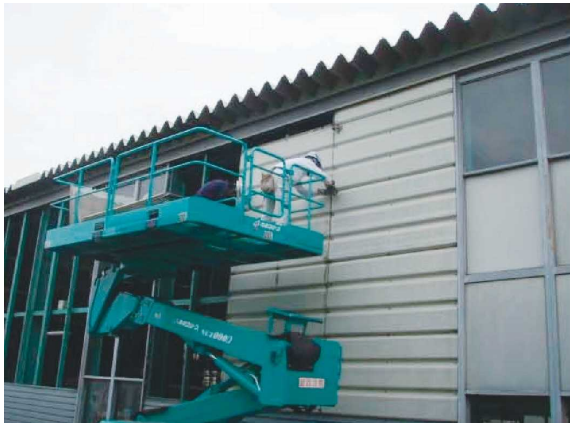
壁金物取外し
