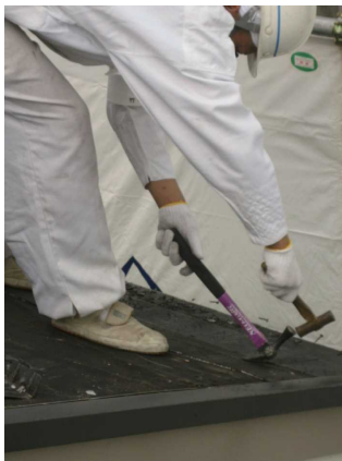
接合固定部分の取外し
