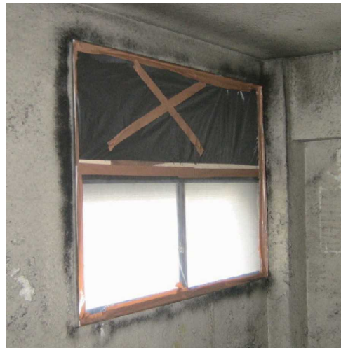
図 3. 27 窓、換気口の養生例
