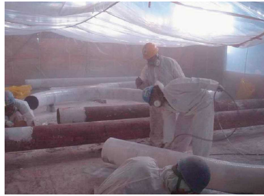
図 3.91 掻き落し作業
