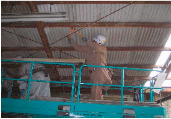
屋根スレート止め金物切断
