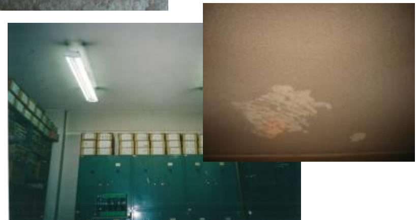
浴室・階段室・金庫室・書庫 ・集合住宅居室等の天井
