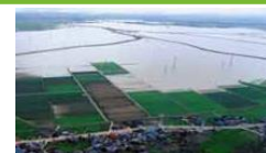
集中豪雨による農地の湛水被害
