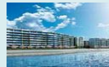
太陽熱供給システムを導入した集合住宅の整備
