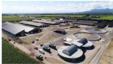
バイオガスプラント
