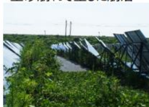
放置されたパネルの現況
