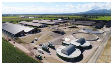
バイオガスプラント
