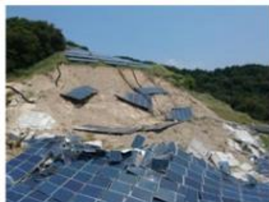
土砂崩れで生じた崩落
