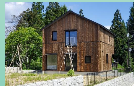
山形県の高断熱省エネ住宅
