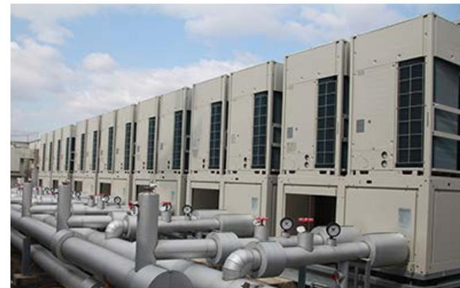
電気式空冷ヒートポンプモジュールチラー イメージ
