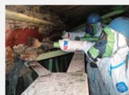
石綿含有吹付け材の除去作業の様子
