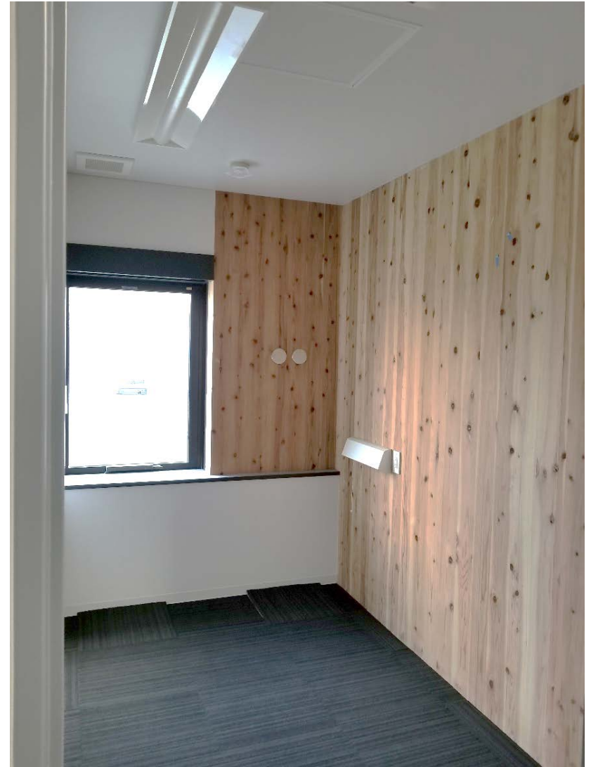
休憩室（壁にCLTを使用） 110
