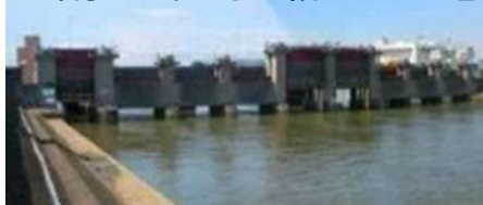
例: 愛知県 日光川水閘門
