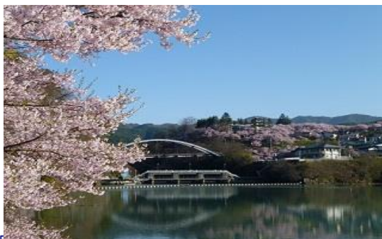
長野県 高遠・奥裾花発電所
