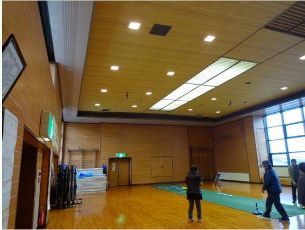
体育館での照明設備の調査
