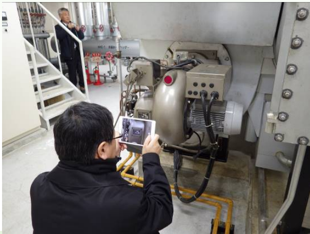
種市庁舎での機械設備調査
