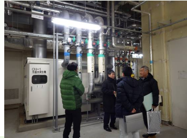
町民文化会館での機械設備調査（ヒアリング）
