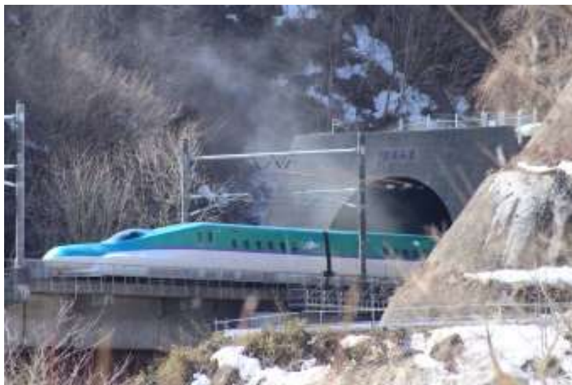
青函トンネル 北海道側出入口
