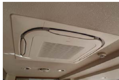
高効率空調設備への更新
