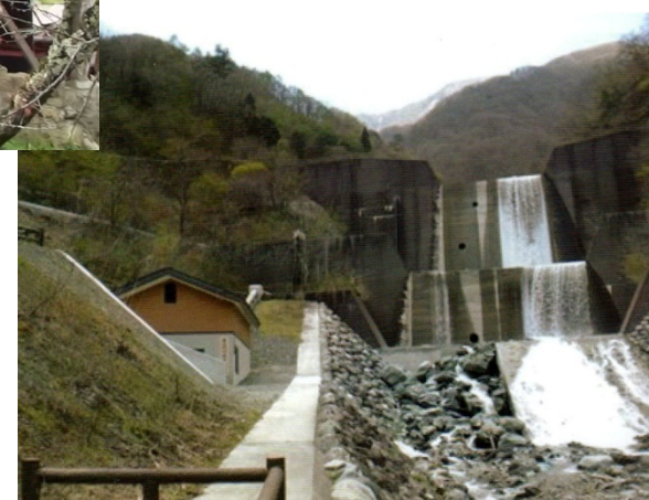
100kW 山梨県 金山沢川発電所 水量:0.32m 3 /秒 有効落差:42m
