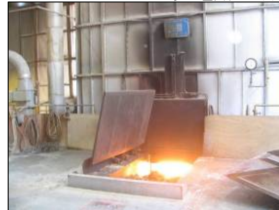
発電用ボイラ
