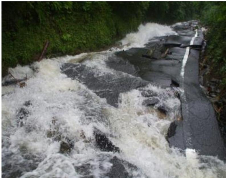
あふれた雨水が舗装を破壊し、道路を崩落させた
