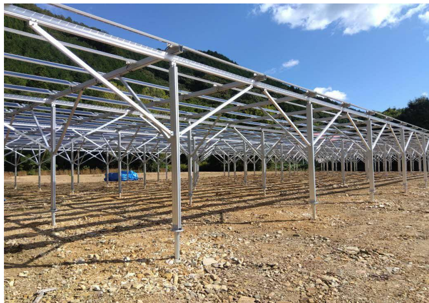
町有地へ設置途中の営農型太陽光発電
