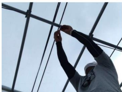
ミストノズルの設置作業
