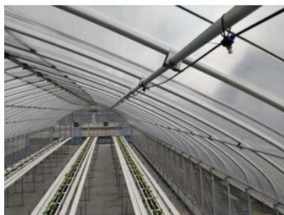
ミストノズルの設置状況
