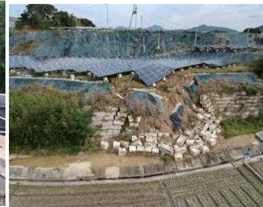
法面保護工が崩れて流出した事例
