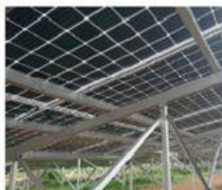
地面からの反射光を吸収する両面パネルを採用。
