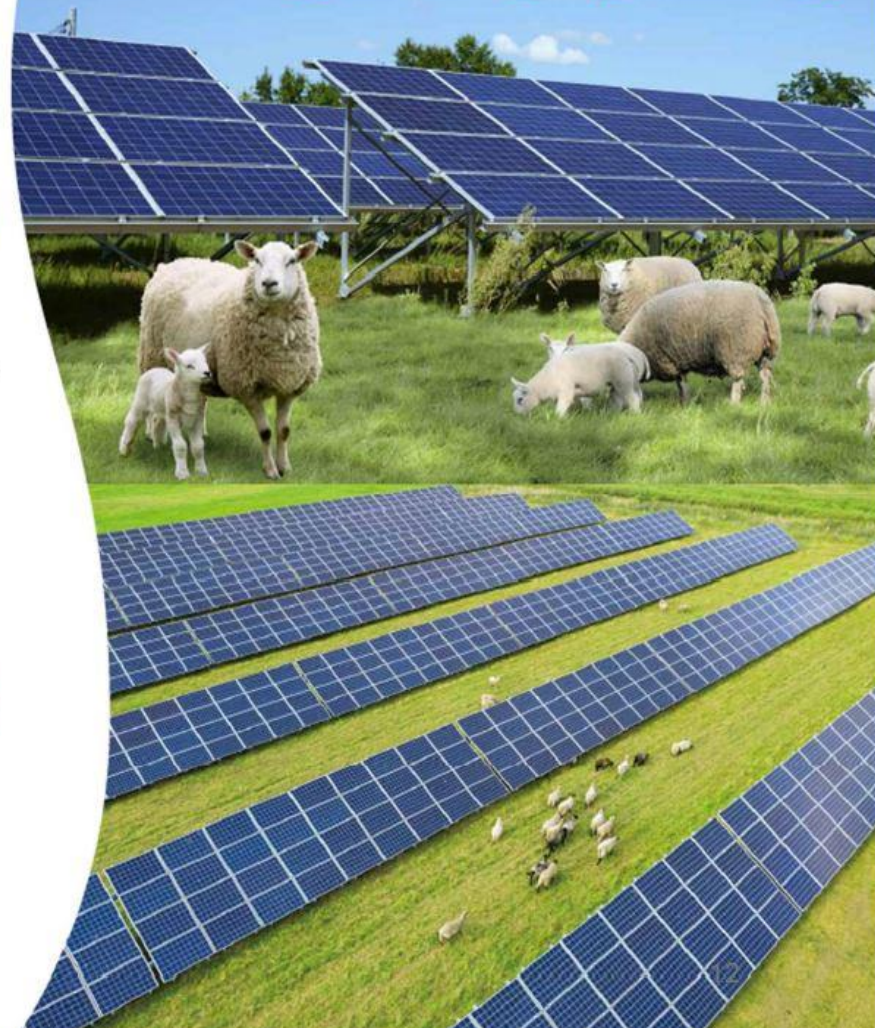
地面からの反射光を吸収する両面パネルを採用。
