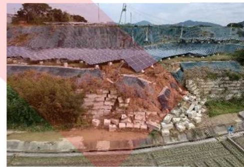
法面保護工が崩れて流出した事例
