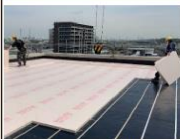
屋根の高断熱化
