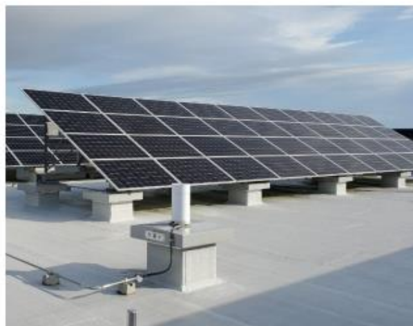
太陽光パネルの設置
