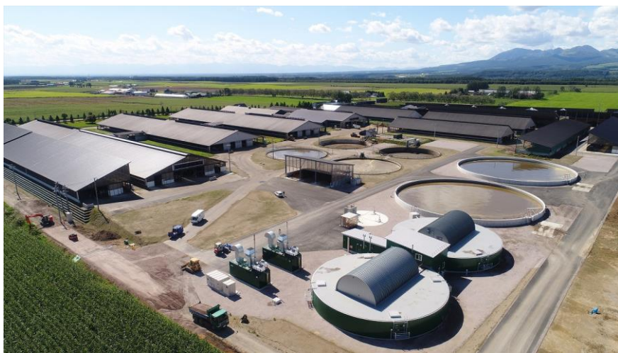
バイオガスプラント
