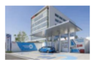
水素ステーション
