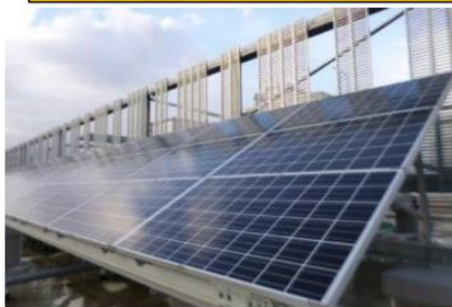
太陽光発電システム(10kW)
