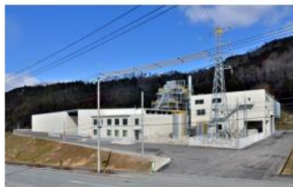
真庭バイオマス発電所 (出力10,000kW)
