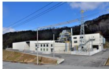
真庭バイオマス発電所 (出力10,000kW)
