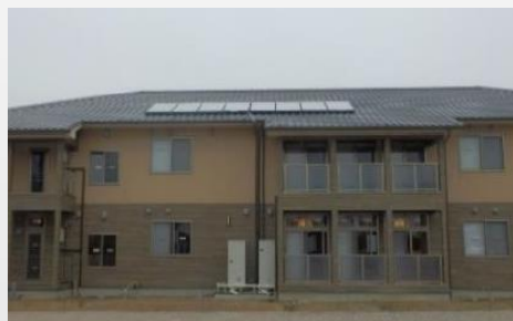
太陽熱利用システムの導入 （福祉施設）
