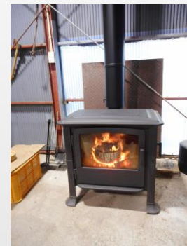
薪ストーブ設置
