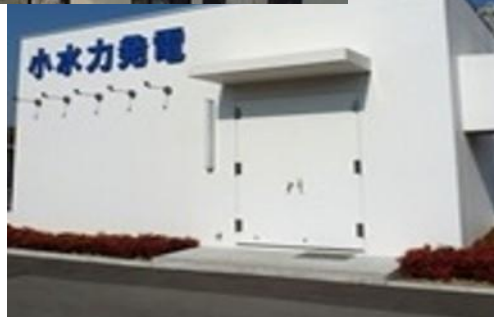
上水道の小水力発電
